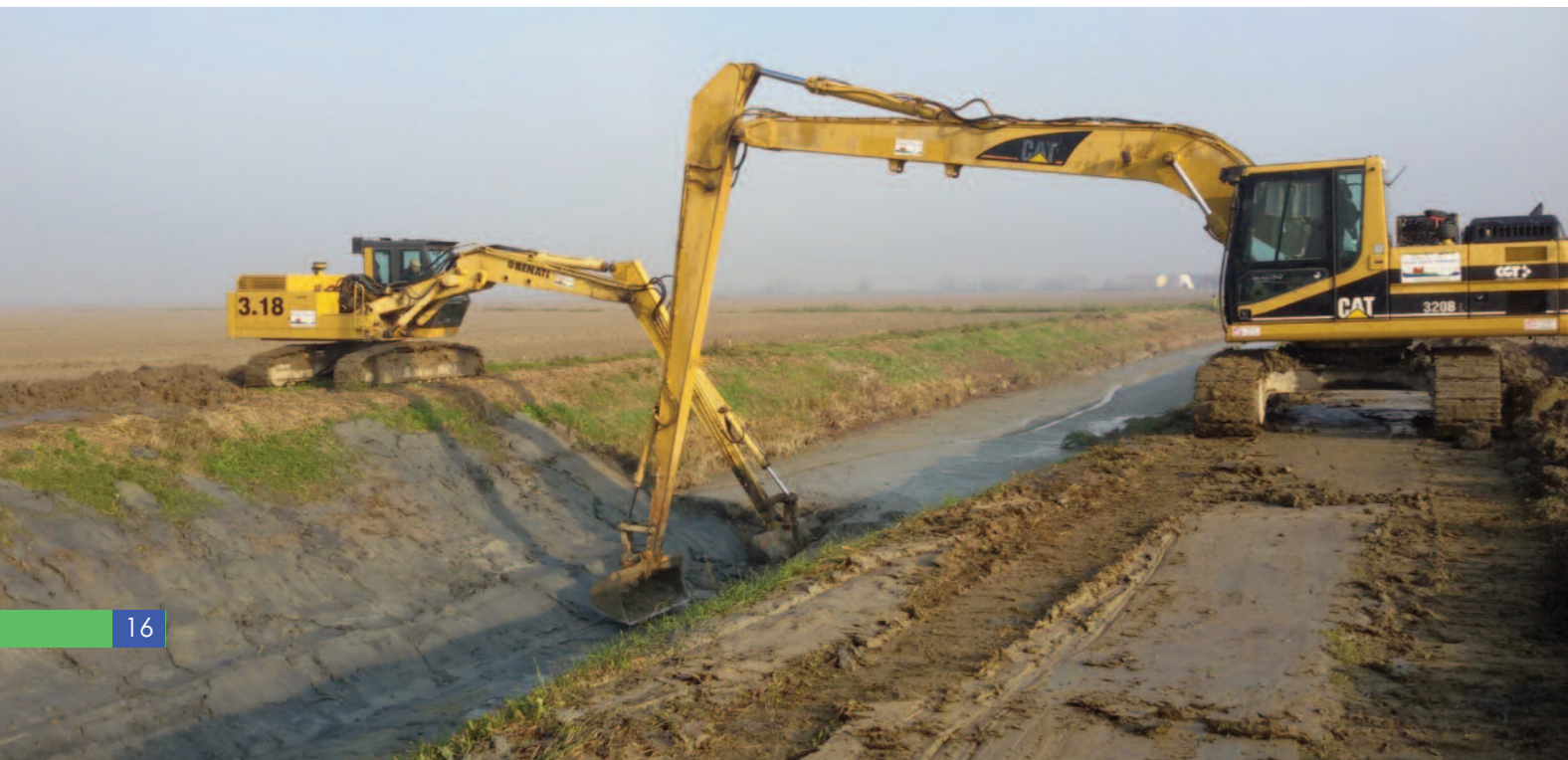
Espurgo Sediment Removal
