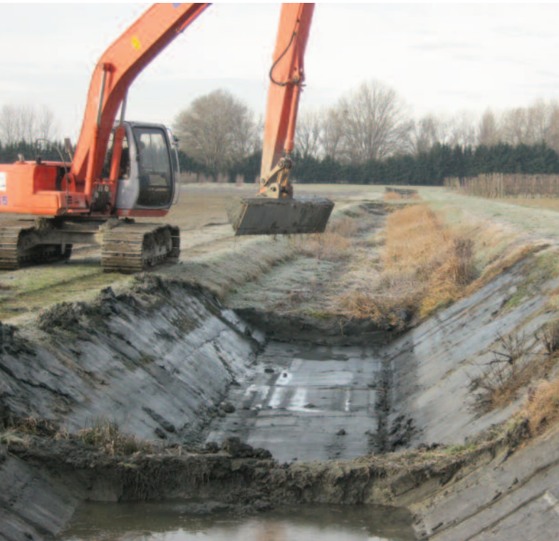
Espurgo Sediment Removal
